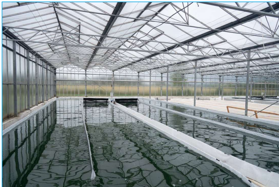
ABBILDUNG 18: RACEWAY POND DER GROßSKALIERTEN SPIRULINAPRODUKTION FÜR DIE CPC AUSGANGSMASSE
